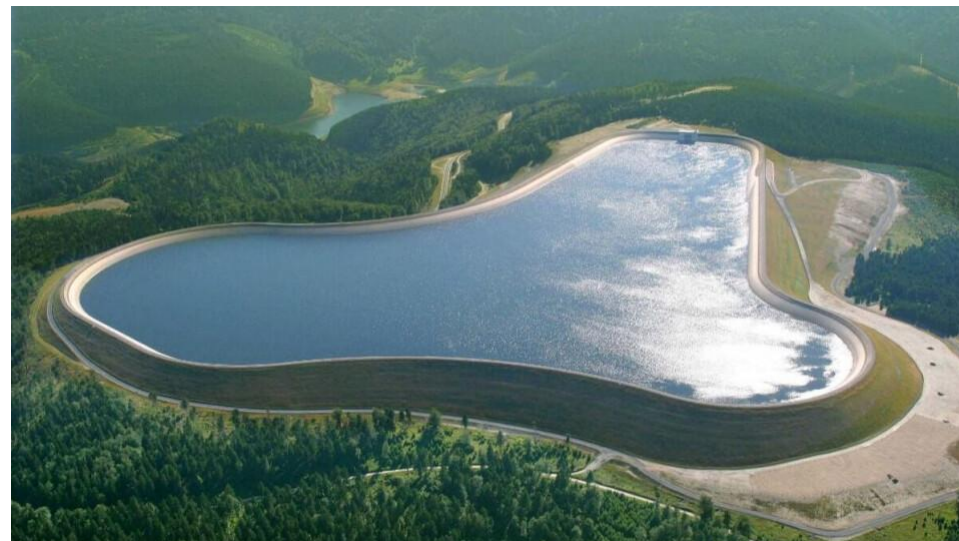
Pumpkraftverket Goldisthal i Tyskland har varit i drift sedan 2004 (1060 MW). Bild: Vattenfall
